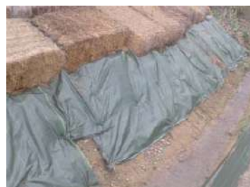
Cubrición de zonas invadidas por caña con pacas de paja y malla anti-hierba para evitar su rebrote tras el desbroce.
