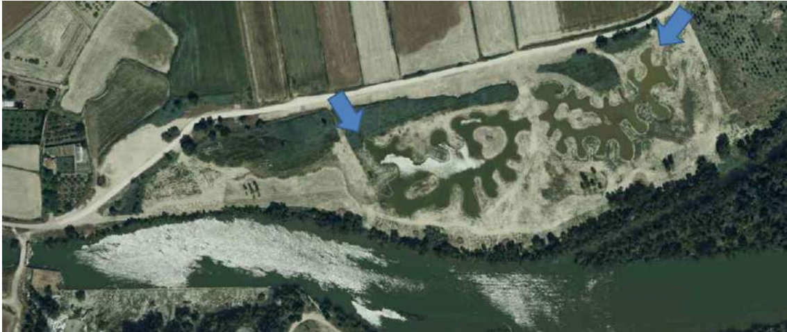
Figura 4. Se observa en la imagen las excavaciones realizadas, con aspecto muy lobulado. Las flechas azules muestran las dos entradas de agua de las que se nutren los humedales creados en el proyecto.
